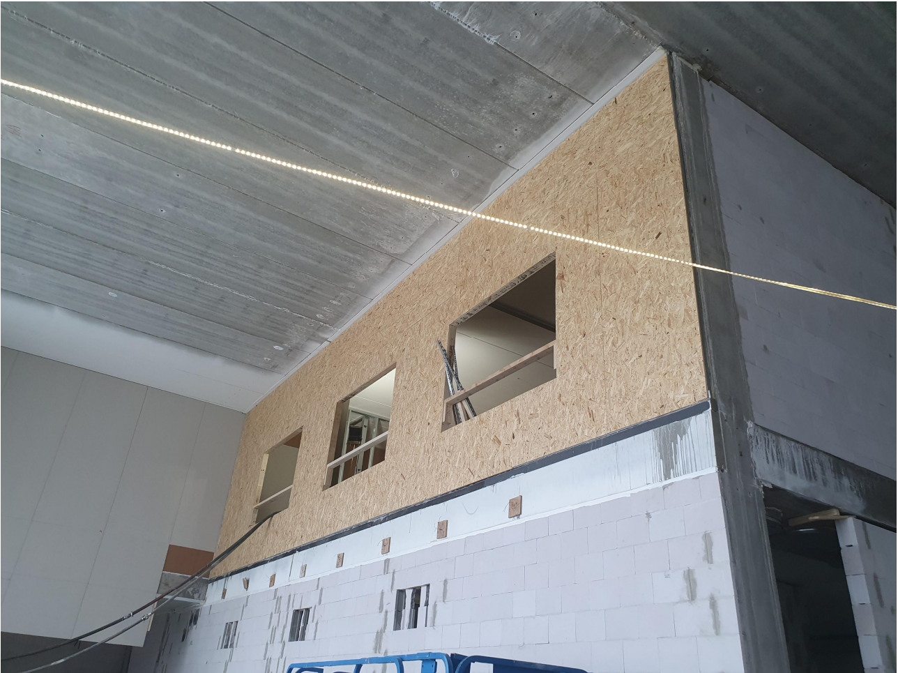
C2-lohkon 2 krs levyväliseinätyöt käynnissä
