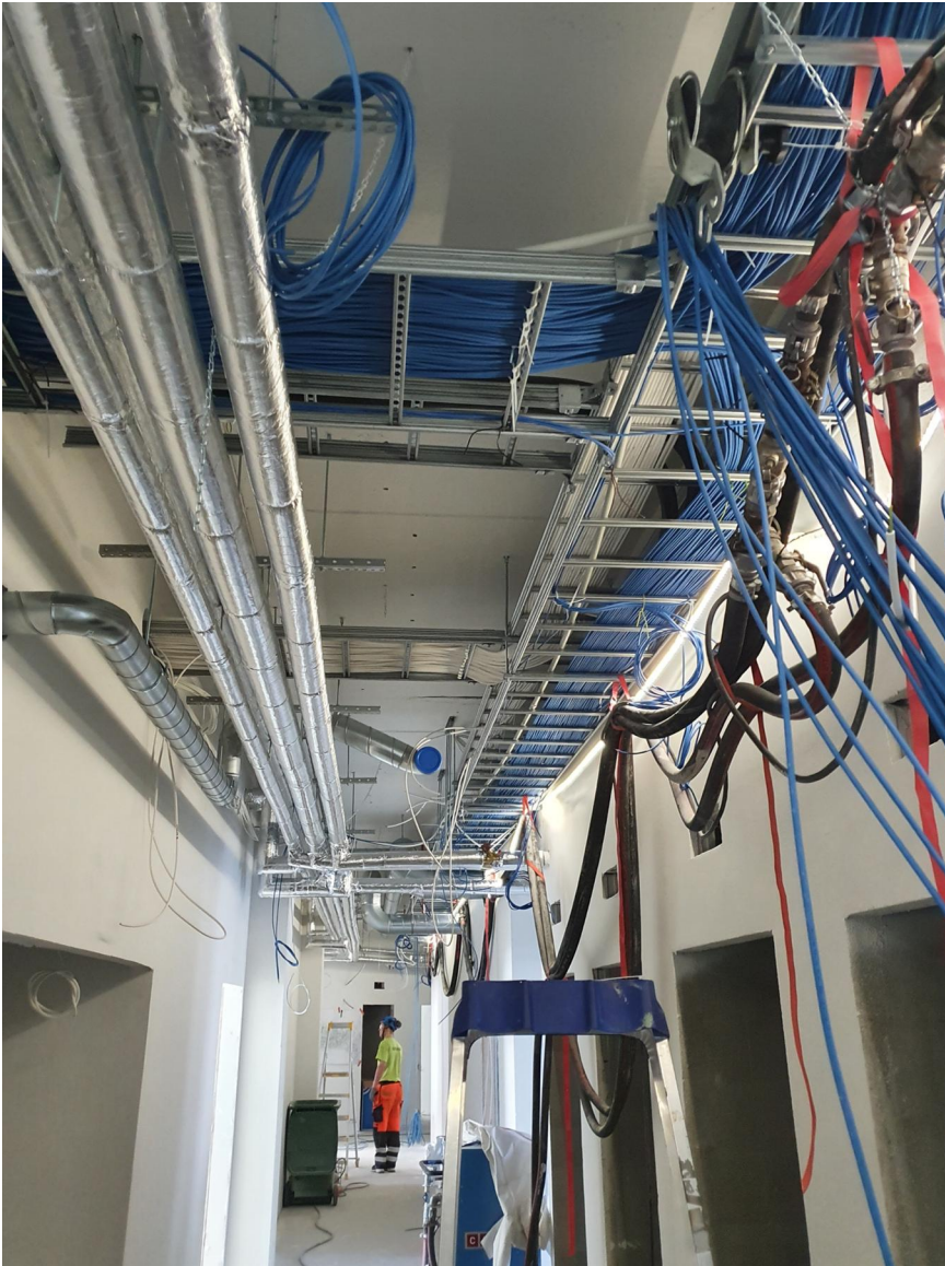
C1-lohkon 2krs kaapelointityöt käynnissä
