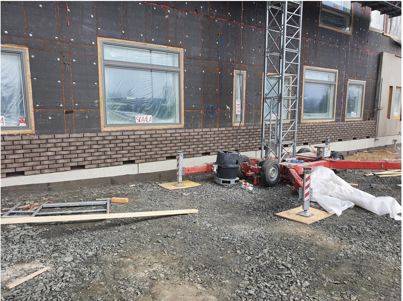
Julkisivumuurauksen työt aloitettu
