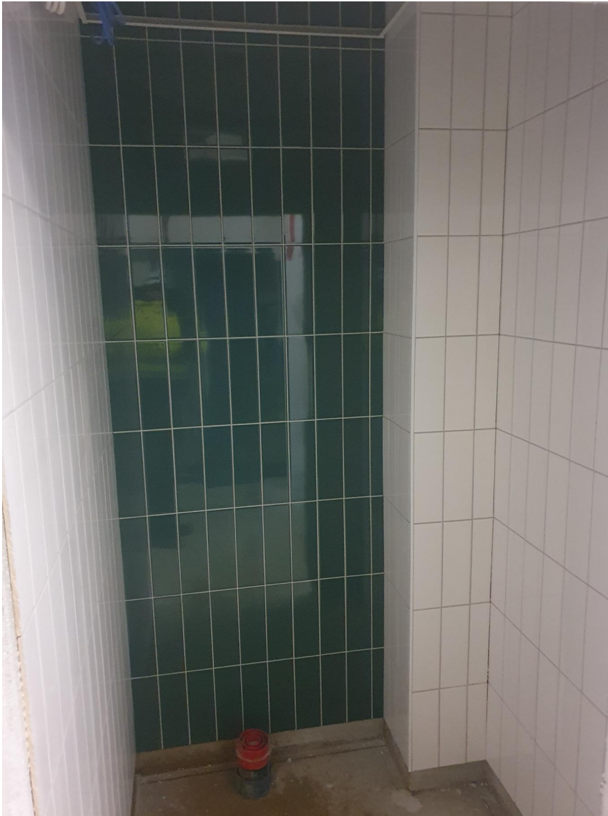
C1-lohkon 2 krs laatoitukset valmiit
