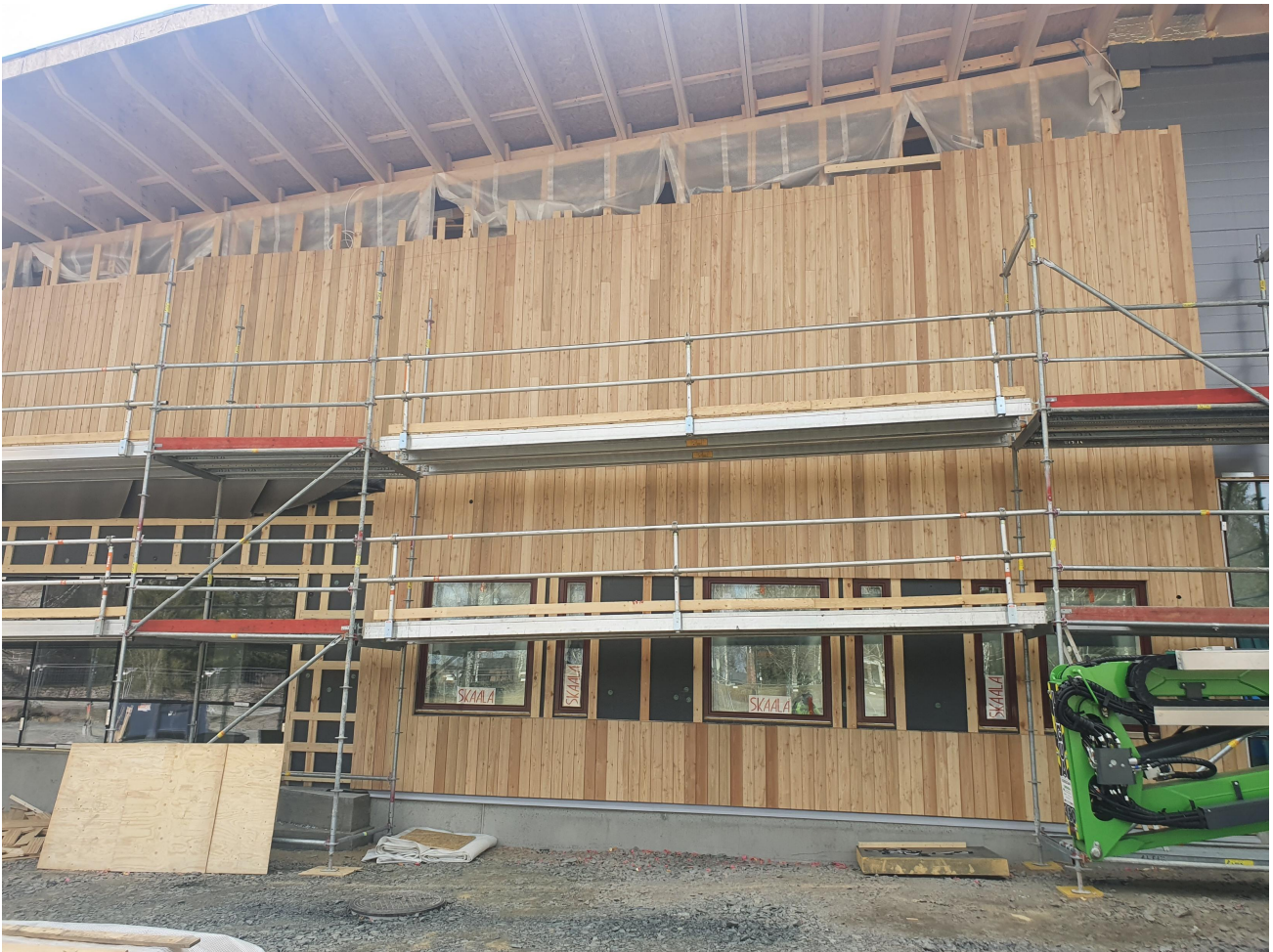
Juvantien puolella aloitettu julkisivupanelointi
