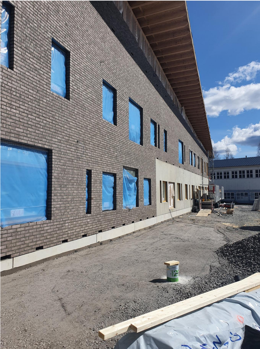
Ensimmäinen seinä muurattu
