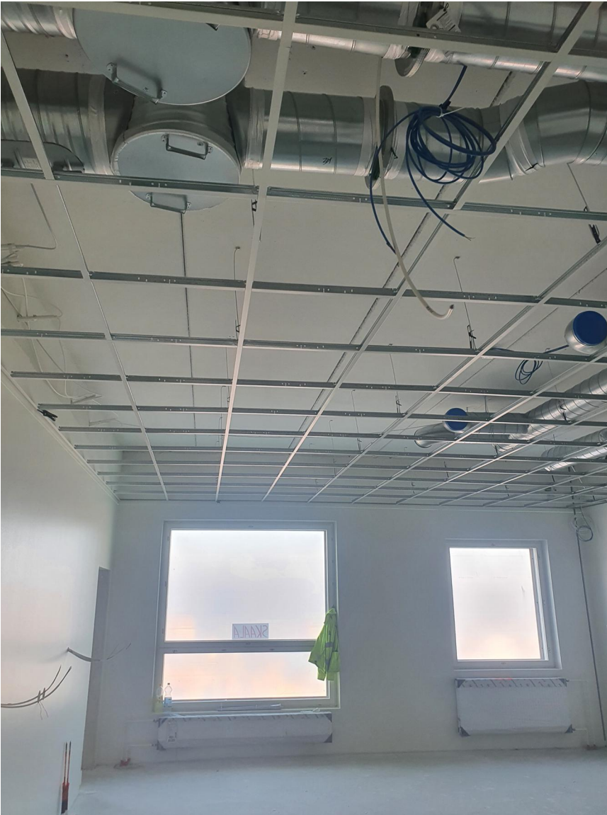
Alakattotyöt jatkuvat C1-lohkolla
