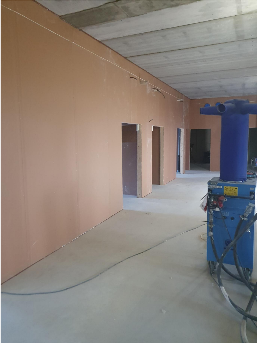
C1-lohkon 2 krs seinien levytys käynnissä
