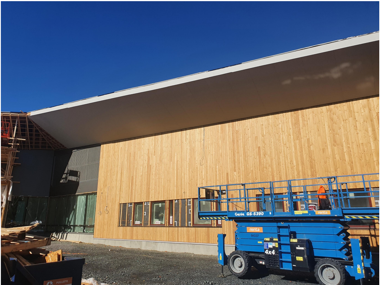
Räystään levytykset käynnissä
