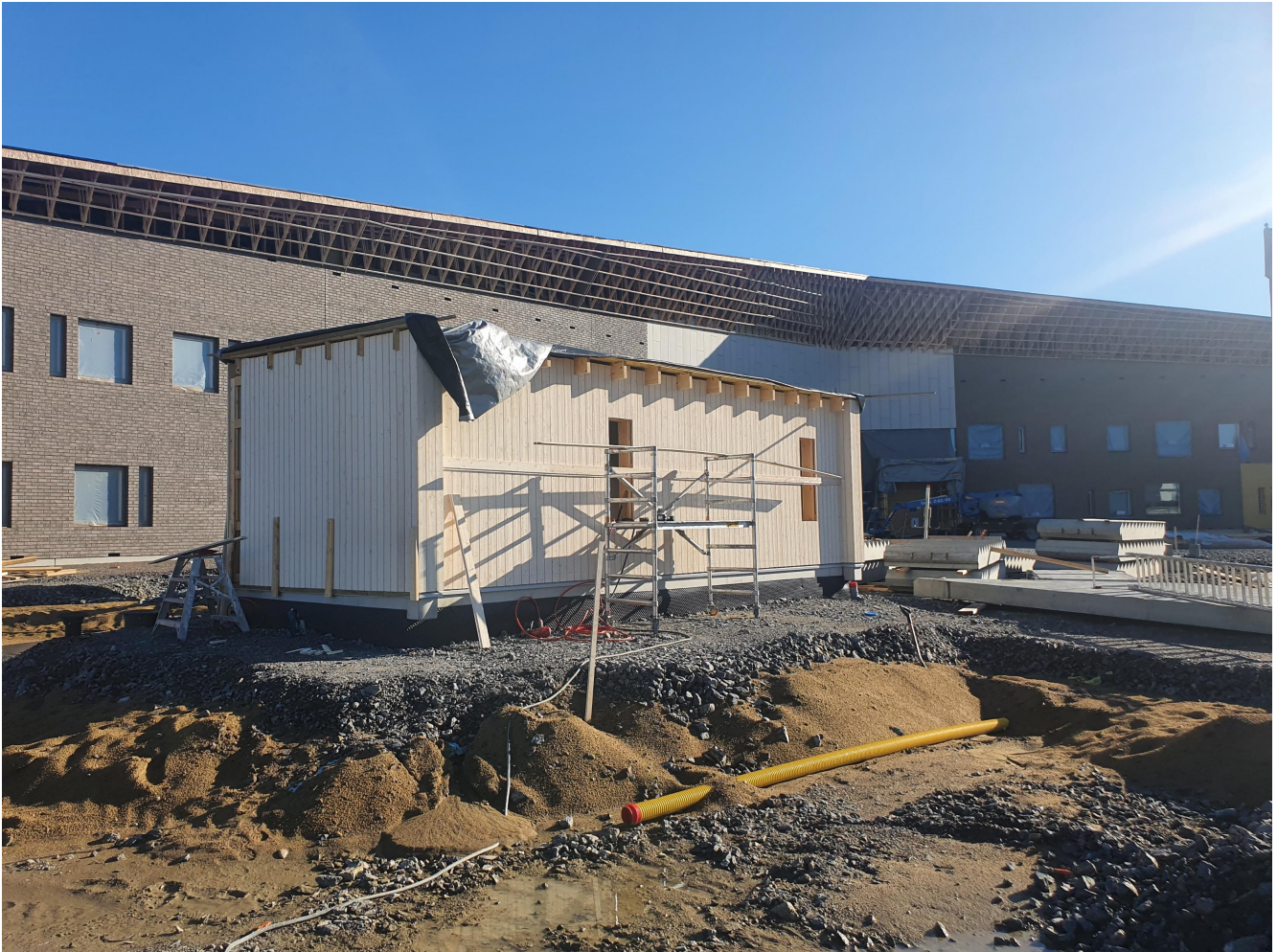
Pihavaraston panelointityöt käynnissä
