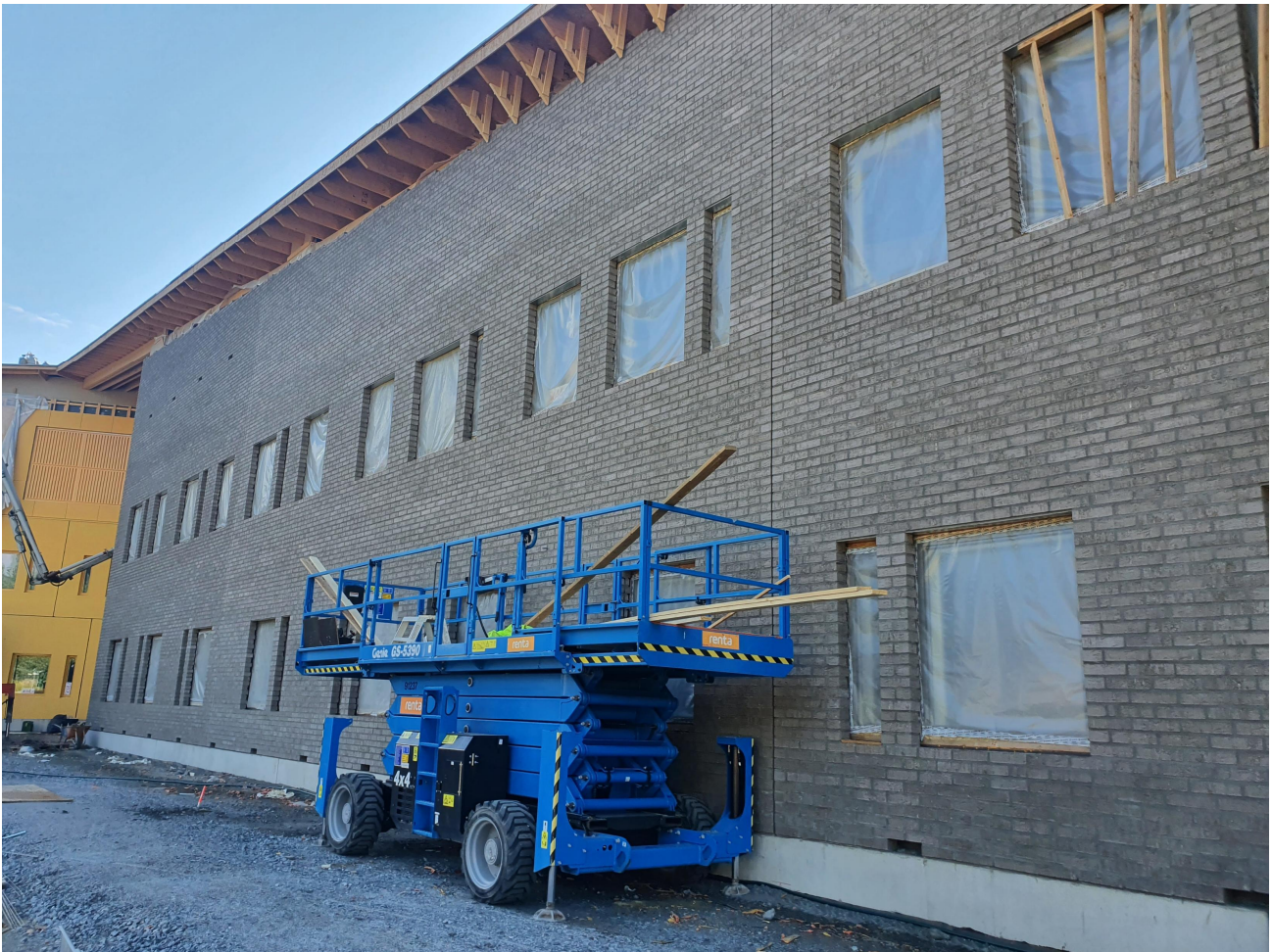
A-lohkon julkisivumuuraus valmistunut
