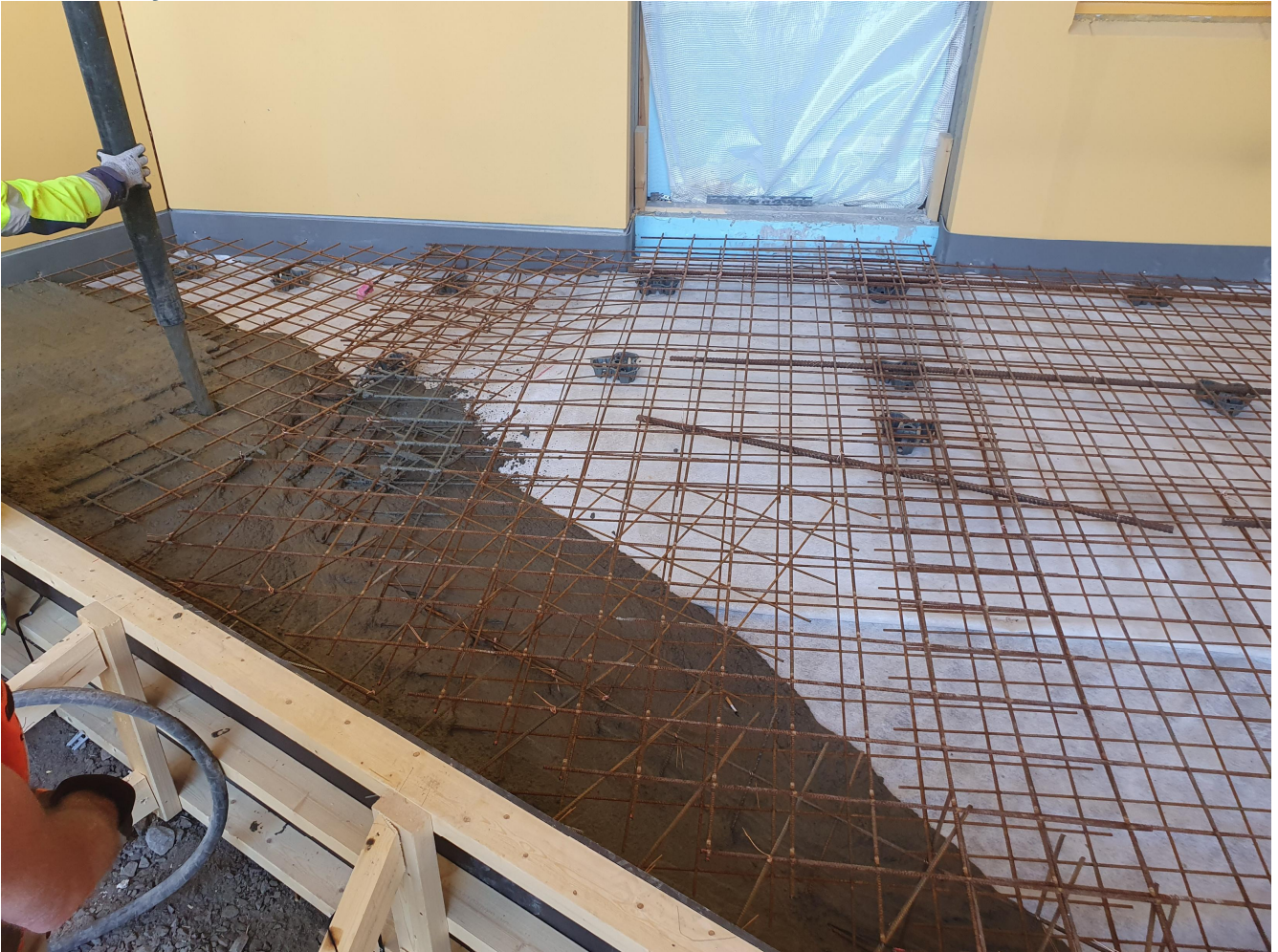
Keittiön lastauslaiturin valu käynnissä
