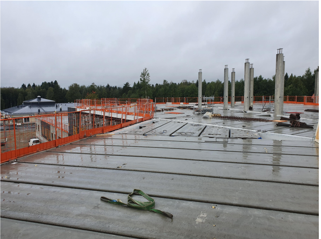
C2-lohkon 2 krs ontelolaatat asennettu.
