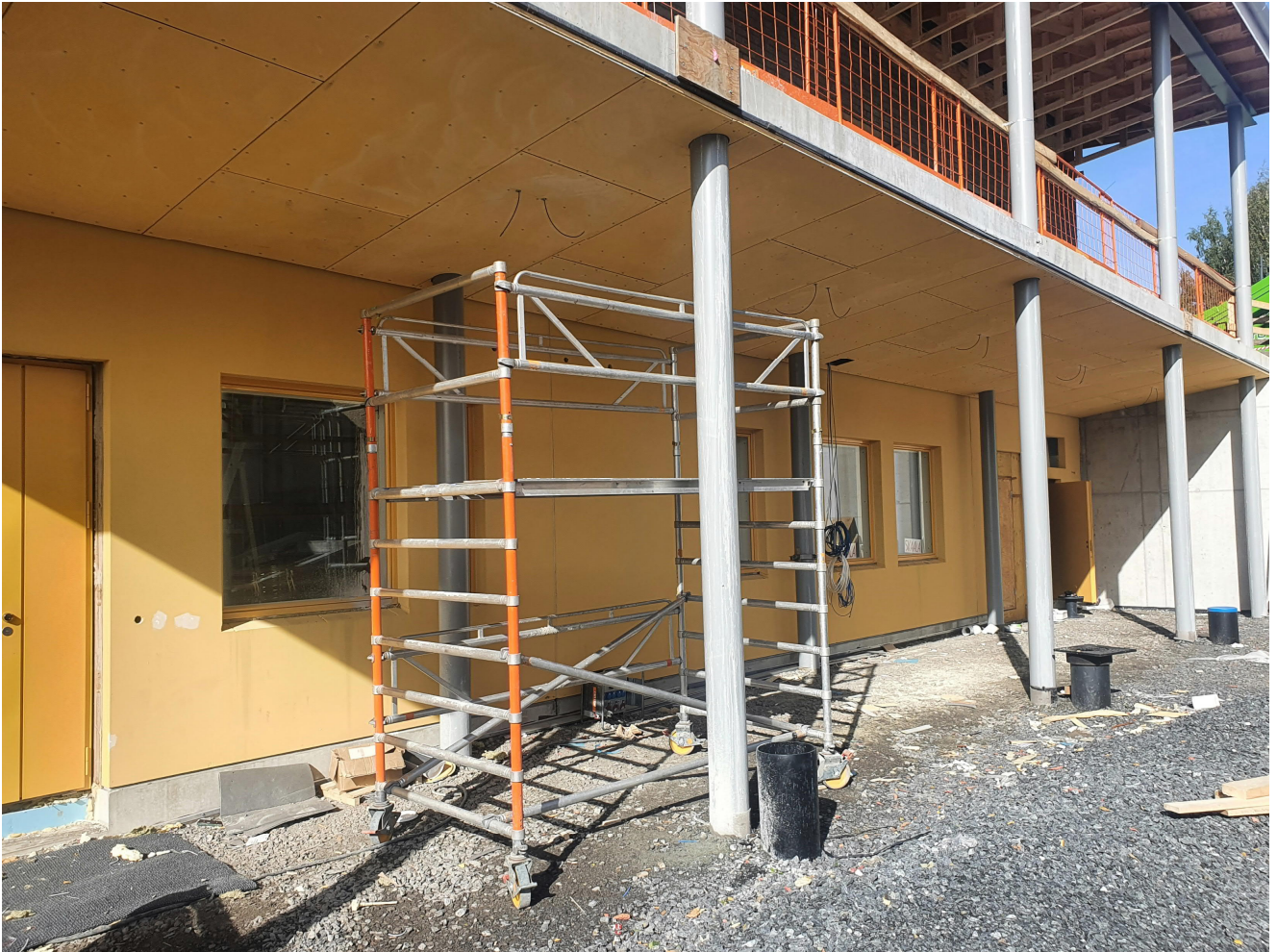
Ulkopuolen maalaukset käynnissä
