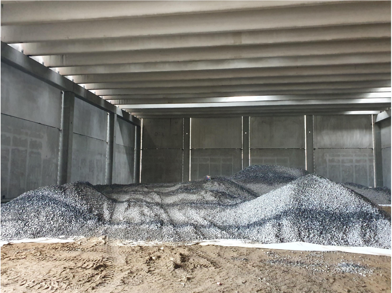
B-lohkon seinien asennukset (Liikuntahalli).
