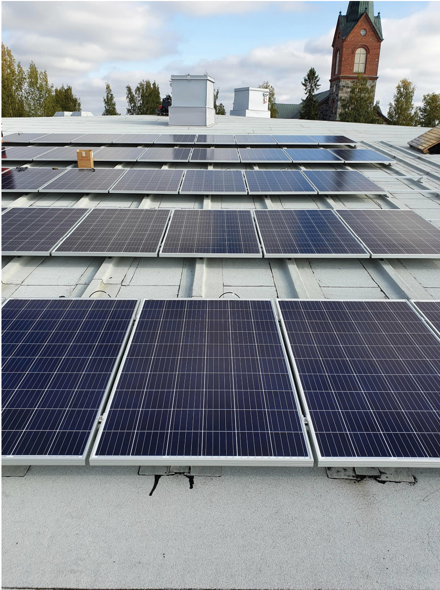
Aurinkopaneelien asennukset käynnissä
