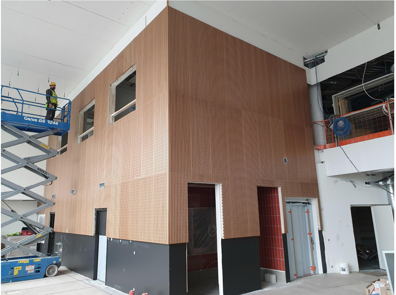
Aulan levytystyöt käynnissä
