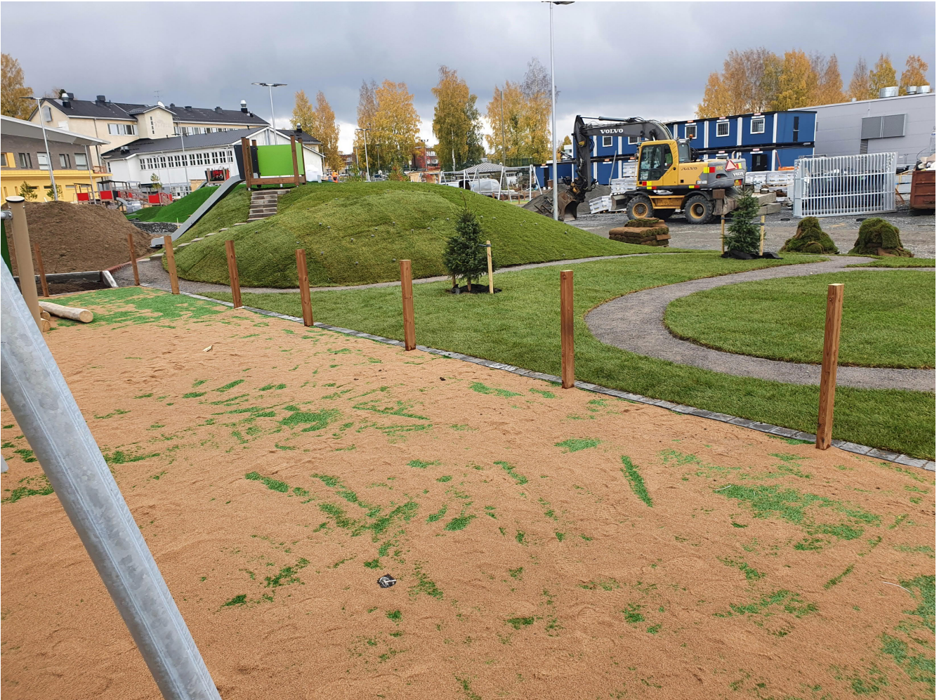
Siirtonurmet asennettu päiväkodin kumpuun.
