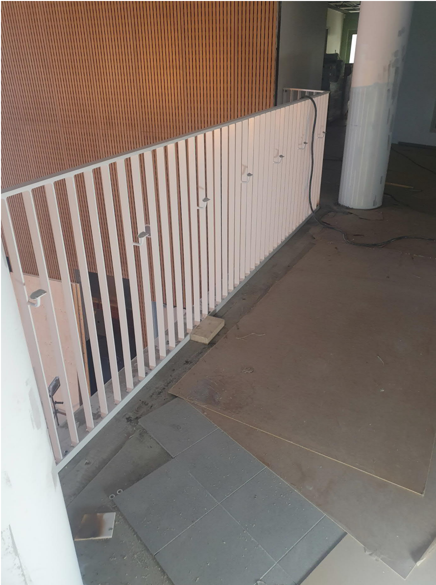
Aulan kaiteiden asennus aloitettu
