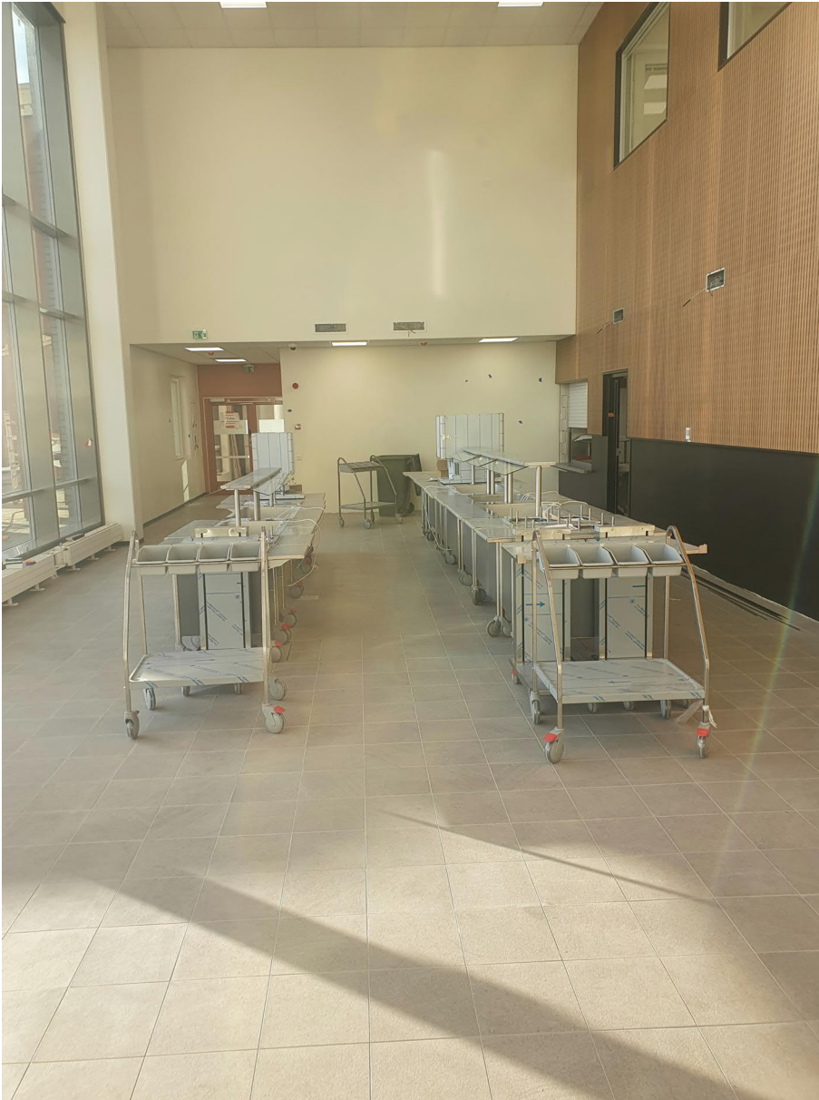
Ruokalan linjastojen asennukset käynnissä
