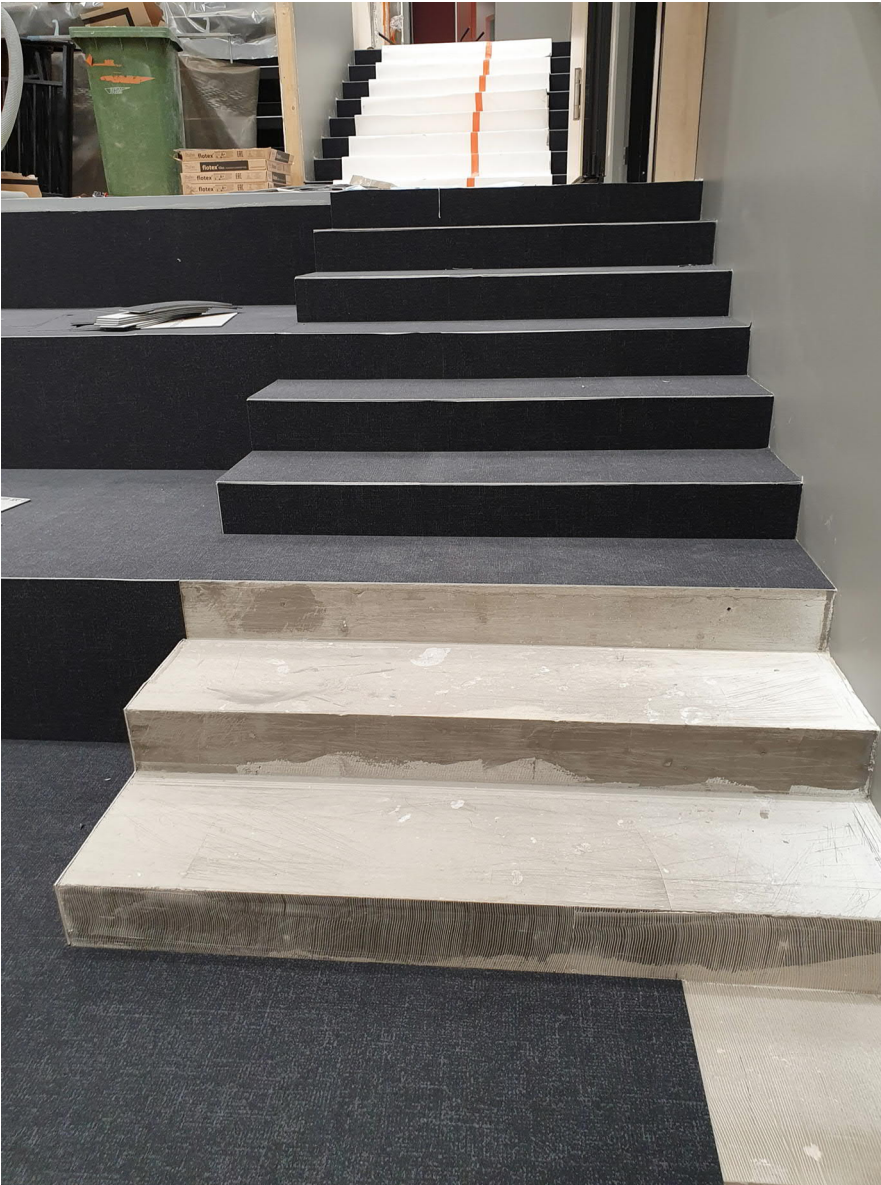
Auditorion mattolattian asennus käynnissä
