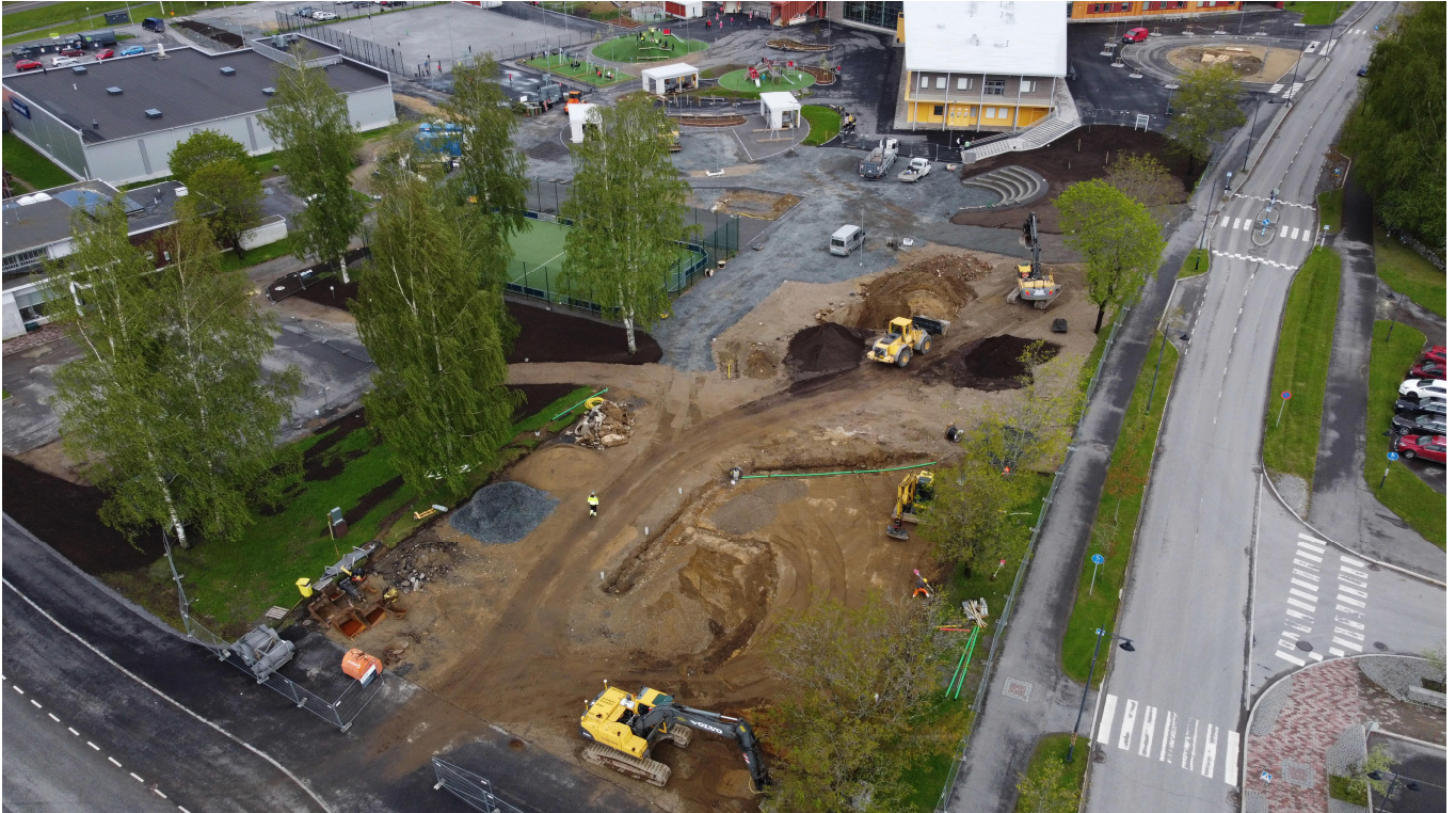
Torialueella työt käynnissä
