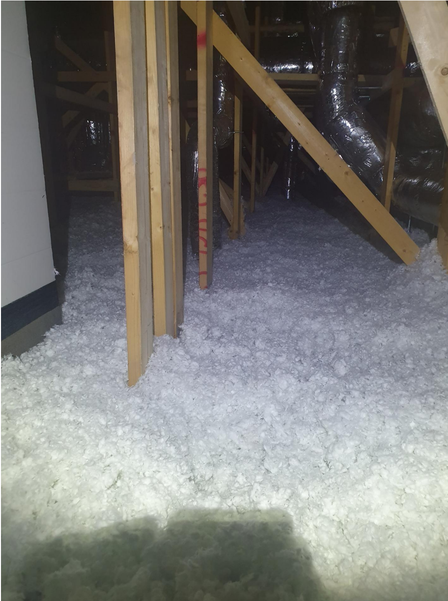
Yläpohjan puhallusvilla eristystä
