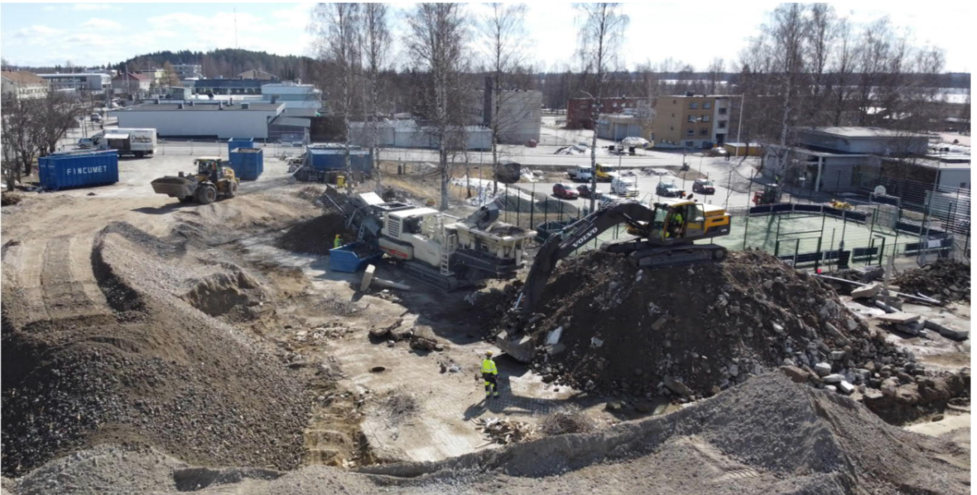
Betonin murskaus käynnissä
